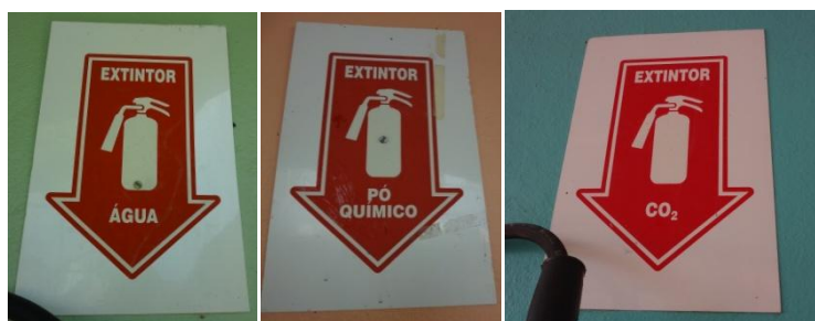
Figura 4.4 – Sinalização de extintores. Fonte: Arquivo pessoal.
