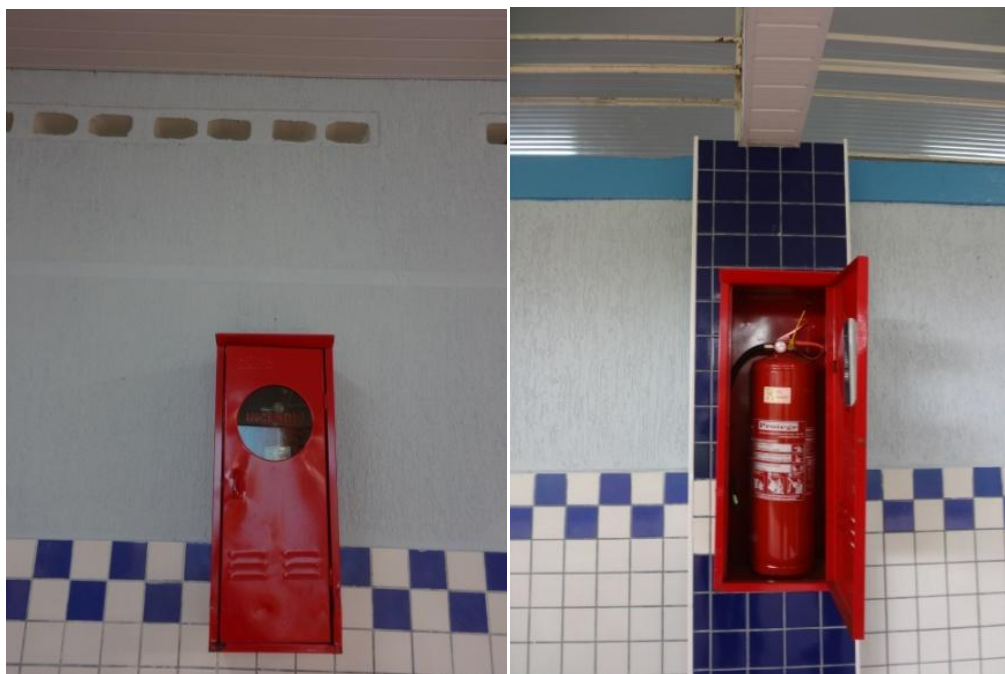
Figura 4.13 – Extintores sem a sinalização. Fonte: Arquivo pessoal.
